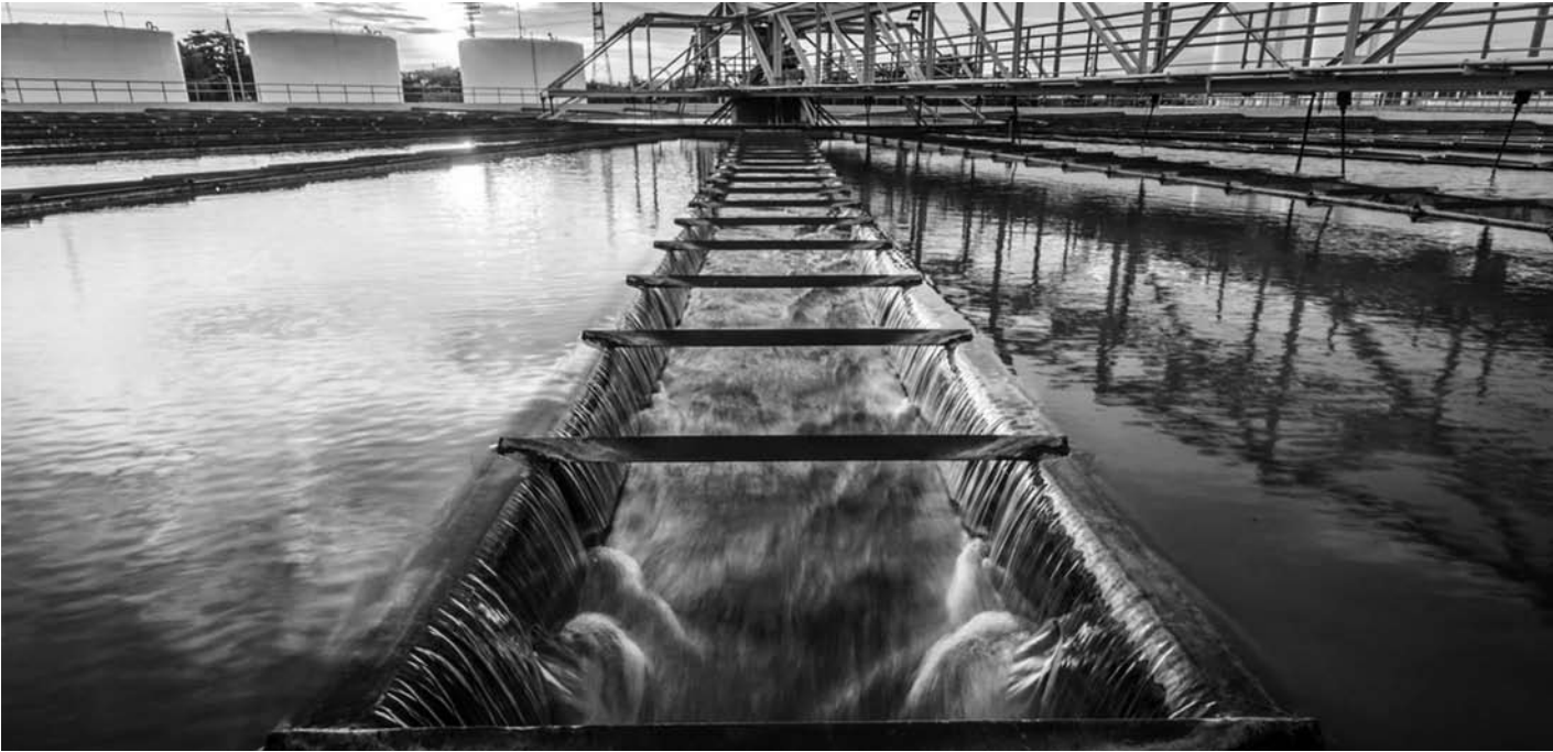
Важнейшая задача, направленная на улучшение состояния бассейна Волги, – это строительство и реконструкция очистных сооружений для жидких стоков.
