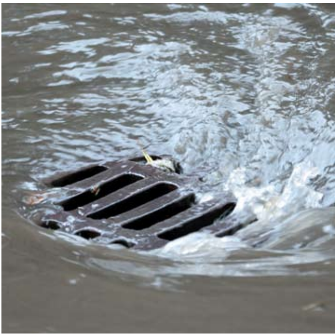
С применением специальной техники было промыто больше километра ливневой канализации. Нужно отметить, что промывка сетей ведется в постоянном режиме: это необходимо, чтобы не нарушать пропускную способность системы.
