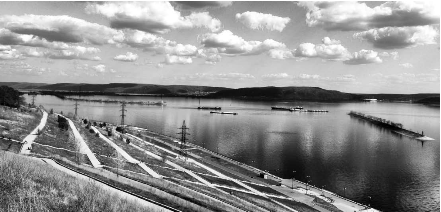
■ Установка новых затворов на очистных сооружениях исключает несанкционированный сброс стоков ливневой канализации Комсомольского района в реку Волгу. Мероприятия реализуются за счет собственных средств компании, без привлечения бюджетных ресурсов.
