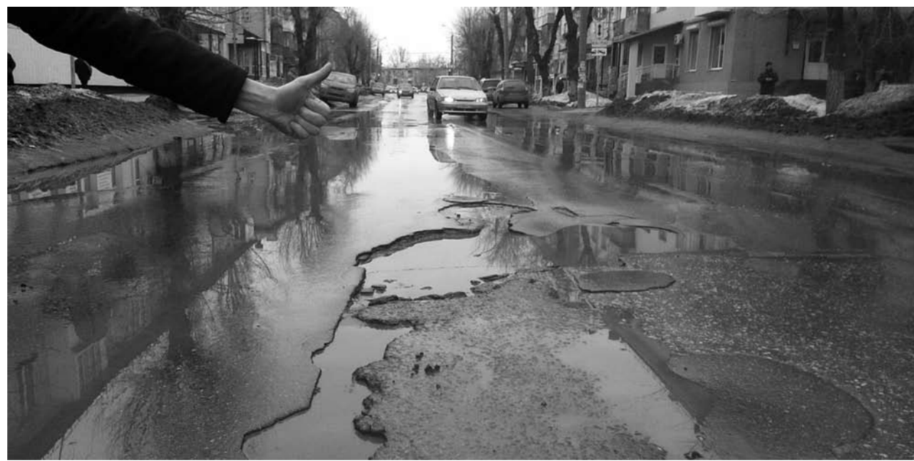
За период с 2016 по 2017 год в Тольятти «Автдоринжиниринг» отремонтировал дороги на сумму свыше 2 млрд рублей. Результат ремонта, как говорится, налицо.
