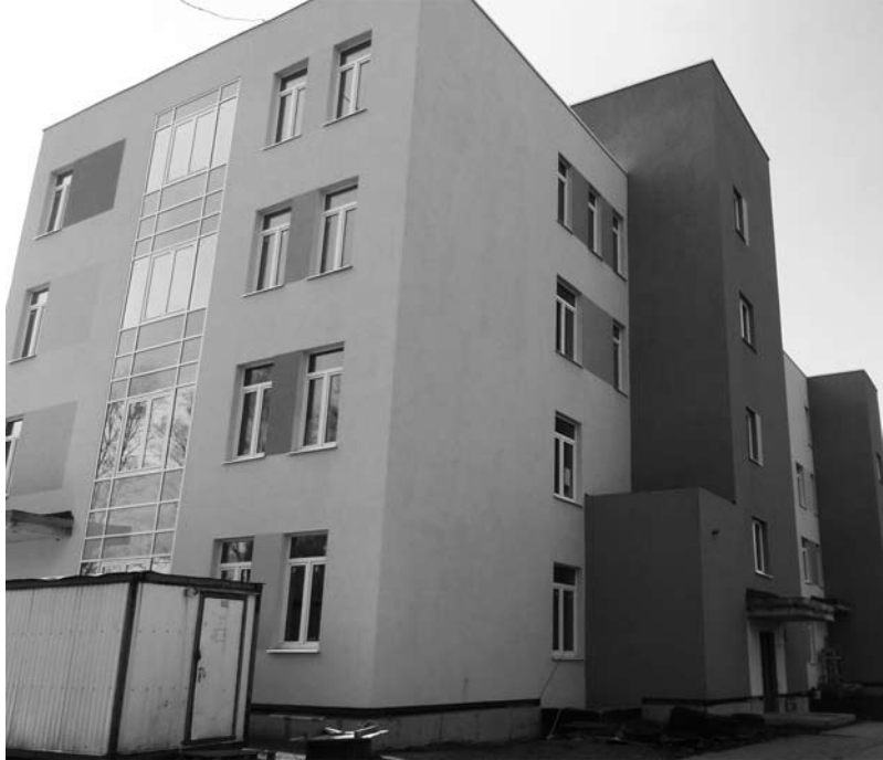
Здание строится по всем нормам и СНиПам, с использованием современных материалов. По многим видам работ готовность составляет 90–100%.
