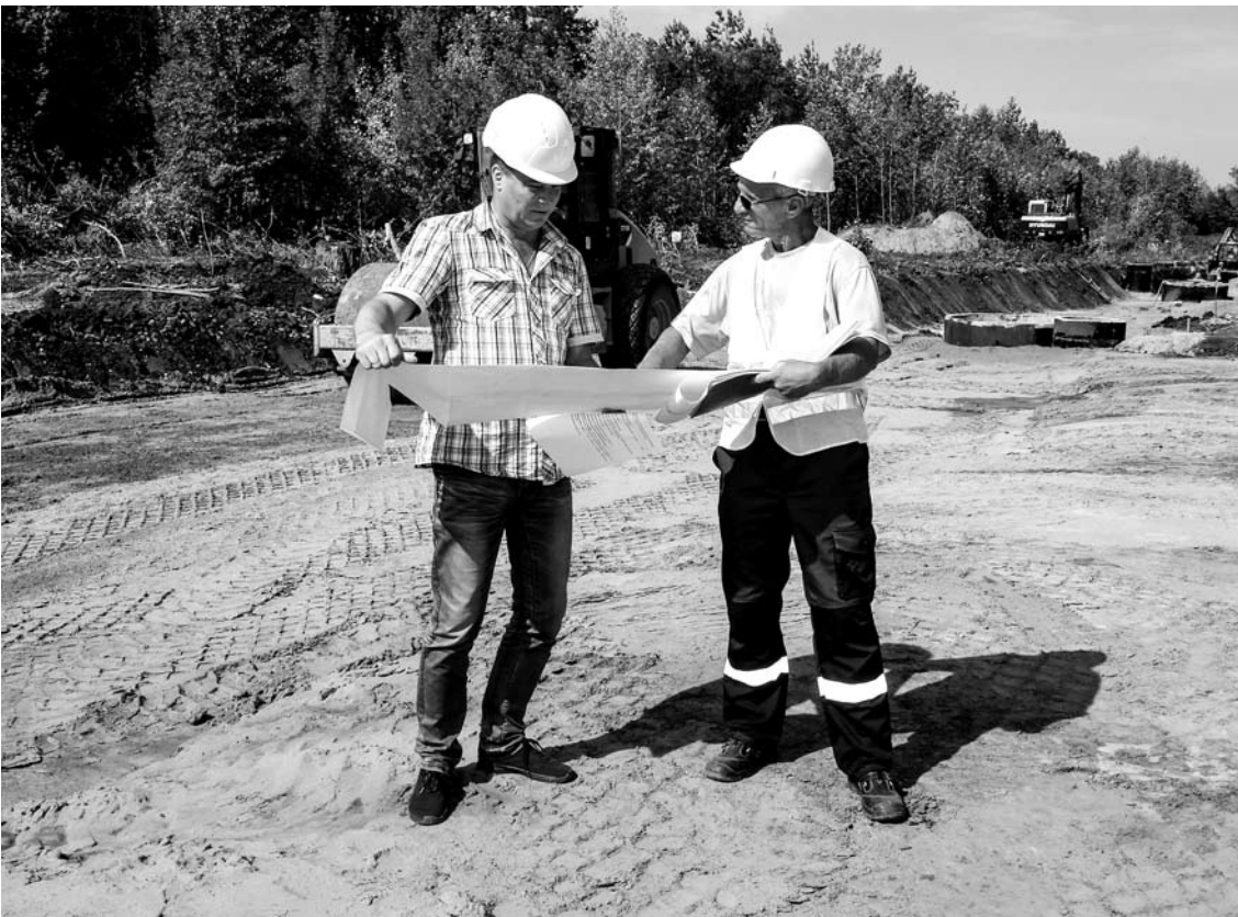
Окончание работ намечено на декабрь текущего года. Гарантия для земляного полотна составит восемь лет, для слоев основания дорожной одежды — шесть, а для нижнего слоя асфальтобетонного покрытия, конструктивных элементов ограничивающих пешеходных ограждений и дорожных знаков — пять лет.
