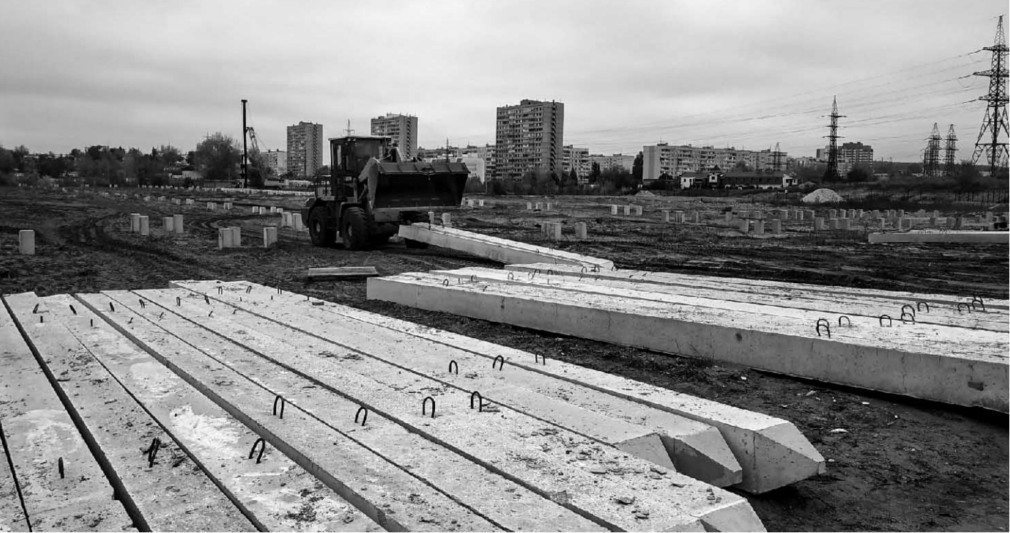
Строительство ведется на территории площадью в 76,3 тыс. гектаров. Благодаря статусу резидента ТОСЭР этот участок «Фабрика бисквитов» в упрощенном порядке получила в аренду в прошлом году. В настоящее время здесь проводятся земляные работы.
