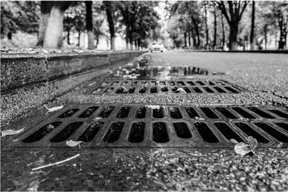
В рамках ежегодного обслуживания и противопаводковых мероприятий муниципальное предприятие МУП «ПО КХ» промывает водоотводящие сети, очищает лотки, чтобы не нарушить пропускную способность системы.
