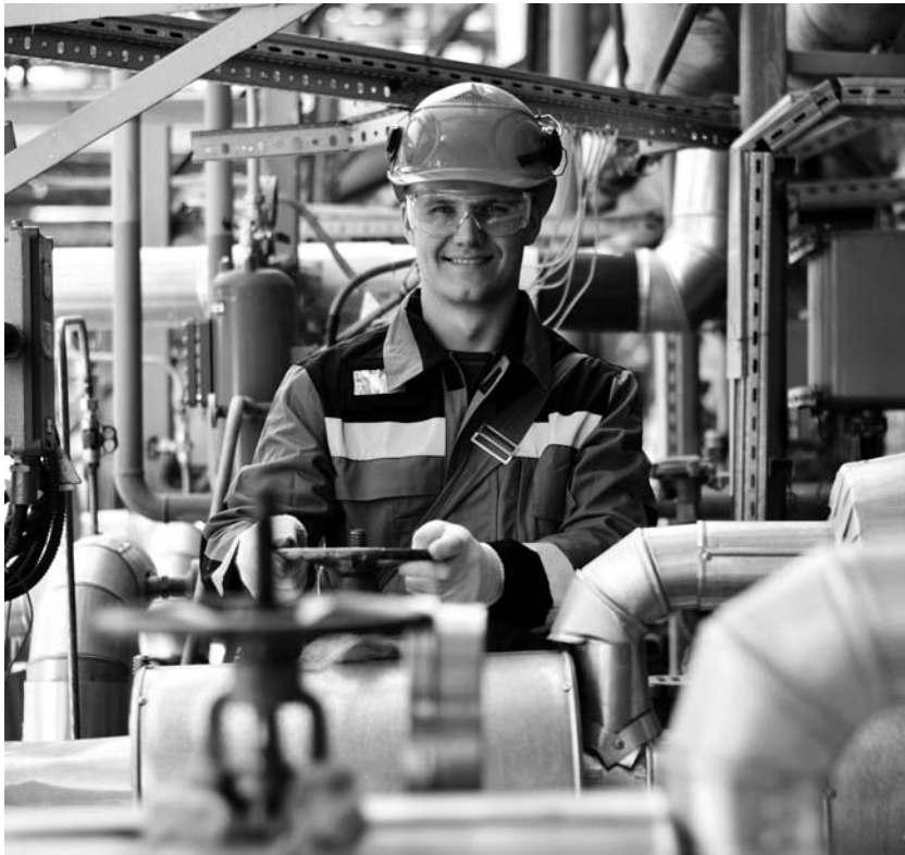
■ В 2018 году на производствах и в товарно-сырьевом цехе «СИБУР Тольятти» установлено девять новых агрегатов. Еще часть оборудования будет обновлена во время остановочного ремонта ближайшей осенью.
