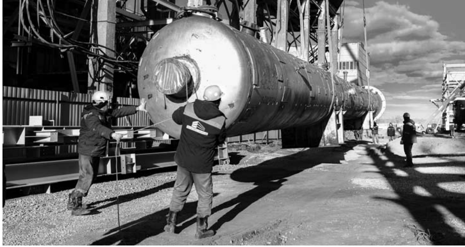
❏ Перекос в один миллиметр в основании может дать на высоте 32 метров отклонение на пять-шесть сантиметров, что недопустимо. Поэтому колонны окончательно закрепят, когда геодезисты удостоверятся в идеальной вертикальности.
