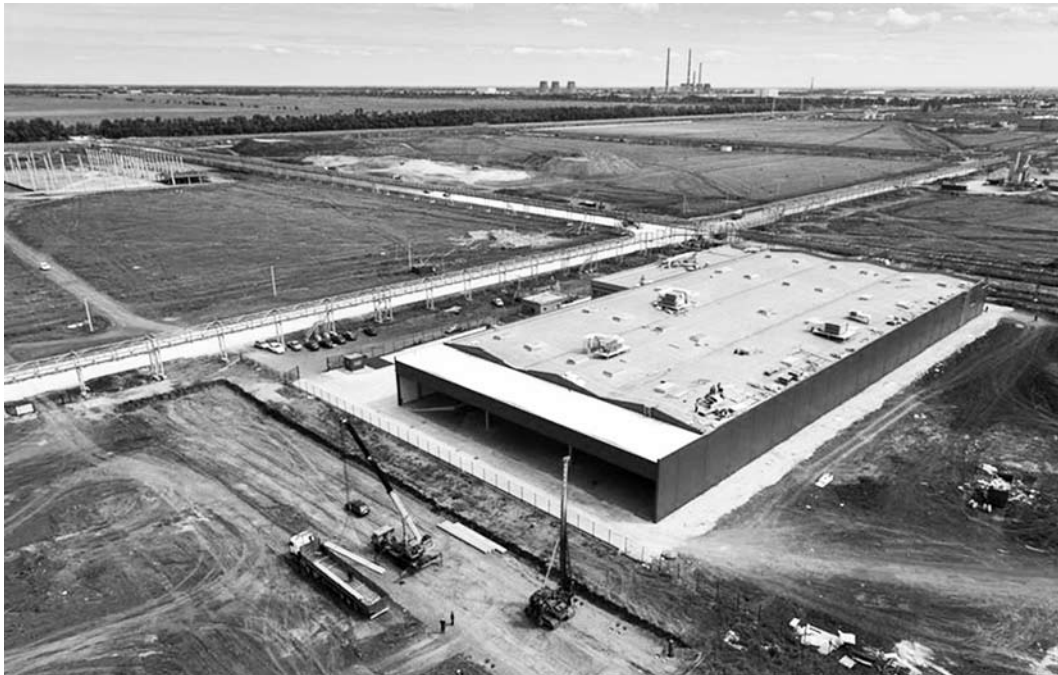
■ Готовность производственной площадки в ОЭЗ была на уровне 80%, когда подрядчик получил уведомление о расторжении договора.
