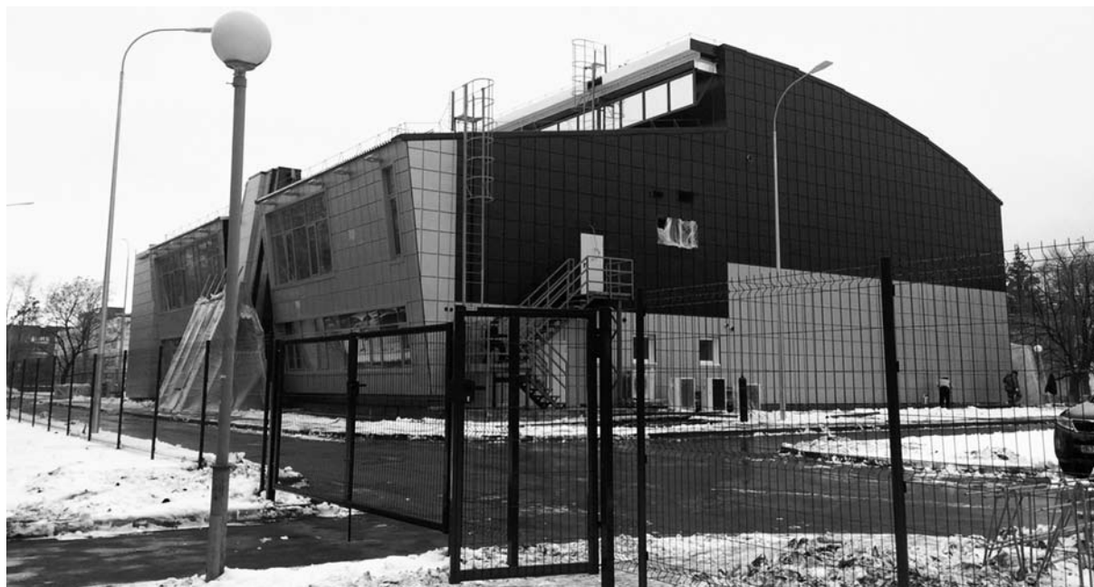
Завершается строительство двухэтажного физкультурно-спортивного комплекса «Союз», площадью 4291 кв. м, расположенного южнее здания № 15 по бульвару Кулибина. Комплекс предназначен для занятий юношей и девушек от 10 лет и старше и взрослых.
